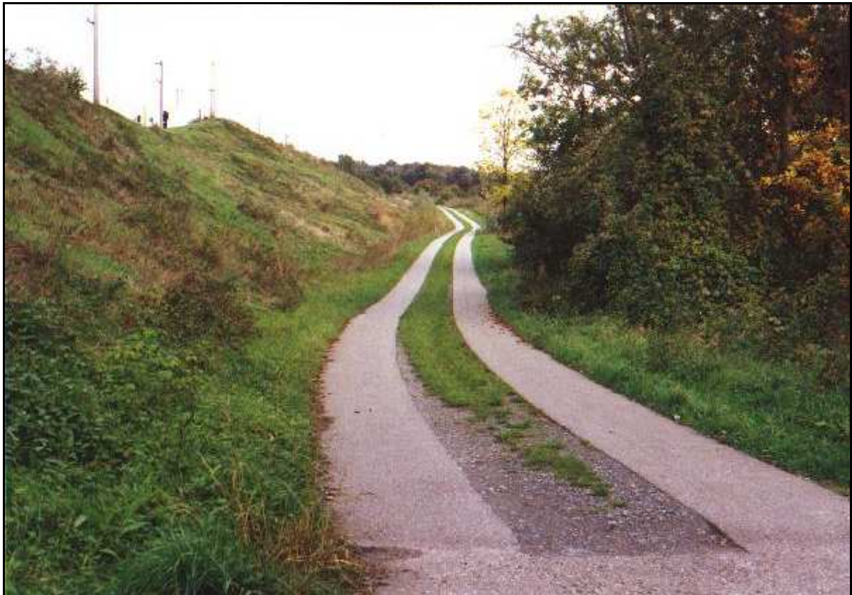
Abbildung 24: Asphaltierter Spurweg am Bahndamm
