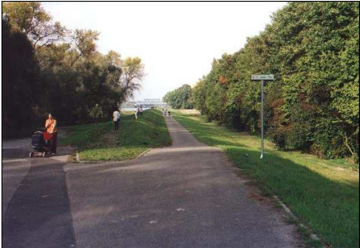
Abbildung 23: Der Haupthochwasserdamm auf Höhe der "NATO - Rampe" (links im Bild)
